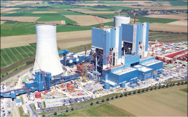
Baustelle des neuen Braunkohlenkraftwerks Neurath (Foto: Helmut Adler, www.fotodesigner.org )
