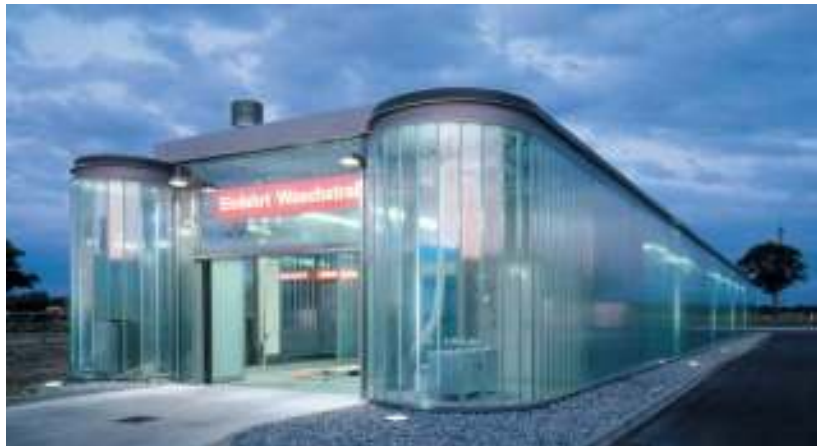
Abb. 13: Gläserne Waschstraße mit „Duplex“-beschichteter Stahlkonstruktion (Foto: Haack+Höpfner Architekten und Johann Hinrichs, München)
