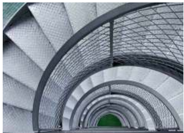
Abb. 2: Treppe Molenturm Friedrichshafen (Foto: Architekt Thomas Hirthe, Friedrichshafen)
