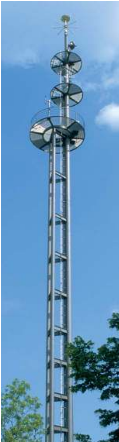
Abb. 1: Antennenempfangsmast Reg TP Leipzig (Foto: Schulitz + Partner Architekten, Braunschweig)
